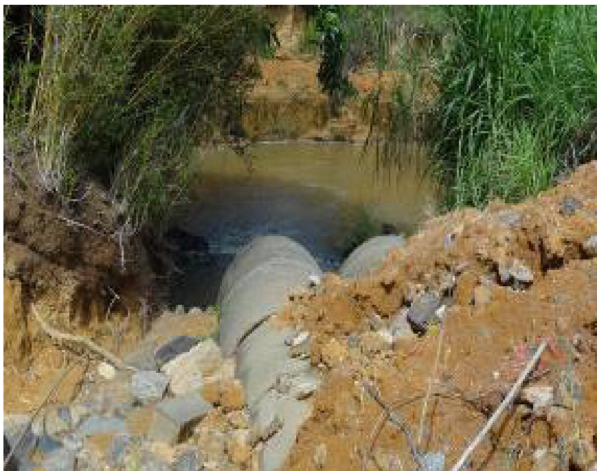
Figura 1 - Canalização do córrego Ubá Pequeno a jusante da captação na área da ETA Peixoto Filho.
