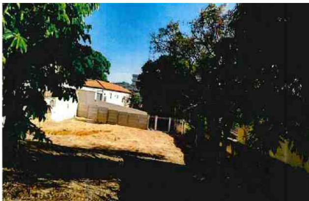
Figura 2 - Cópia de fotografia apresentando demolição integral do bem cultural constante do Relatório Fotográfico.
