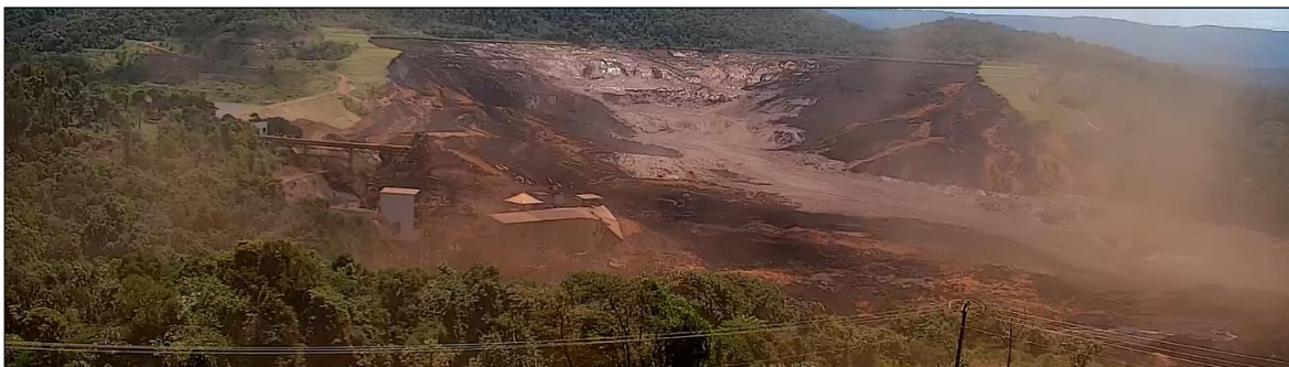
Figura 18 – Vista Frontal do início do rompimento da Barragem 1 - Mina Córrego do Feijão, Complexo Paraopeba - VALE S. A., Brumadinho/MG. Fonte: B1 – CAM1 – BARRAGEM – 25.01.2019 – 12:28:35
