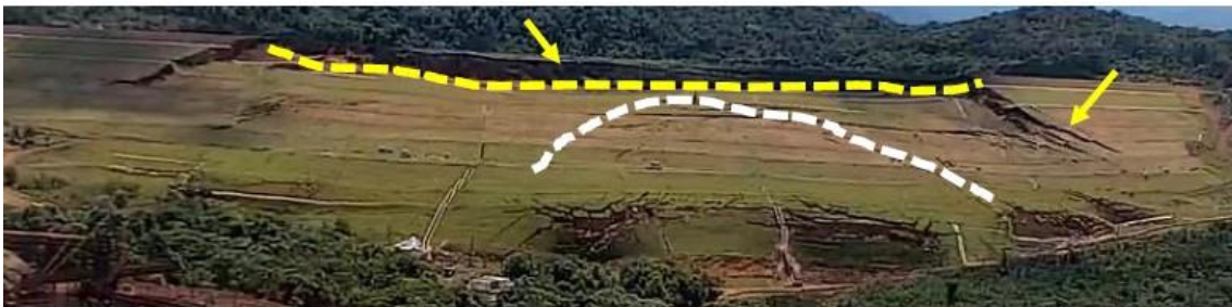
Figura 10 – Vista Frontal do rompimento da Barragem 1 - Mina Córrego do Feijão, Complexo Paraopeba - VALE S. A., Brumadinho/MG. Fonte: B1 – CAM1 – BARRAGEM – 25.01.2019 – 12:28:29
