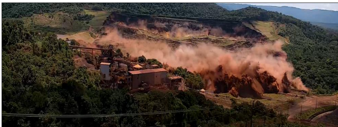
Figura 16 – Vista Frontal do início do rompimento da Barragem 1 - Mina Córrego do Feijão, Complexo Paraopeba - VALE S. A., Brumadinho/MG. Fonte: B1 – CAM1 – BARRAGEM – 25.01.2019 – 12:28:45
