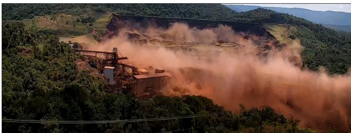
Figura 17 – Vista Frontal do início do rompimento da Barragem 1 - Mina Córrego do Feijão, Complexo Paraopeba - VALE S.A., Brumadinho/MG. Fonte: B1 – CAM1 – BARRAGEM – 25.01.2019 – 12:28:55
