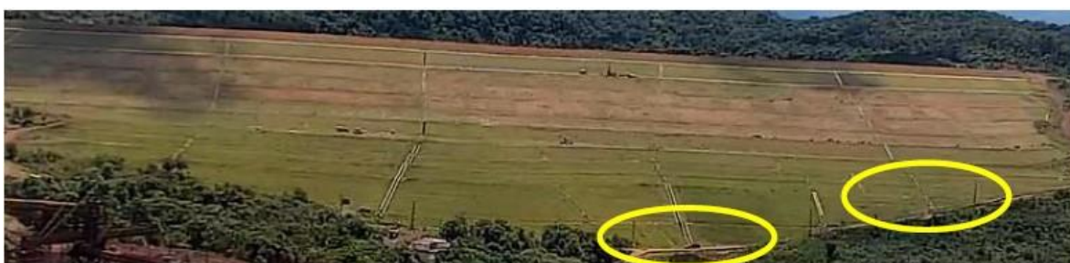
Figura 05 – Vista Frontal do início do rompimento da Barragem 1 - Mina Córrego do Feijão, Complexo Paraopeba - VALE S. A., Brumadinho/MG. Fonte: B1 – CAM1 – BARRAGEM – 25.01.2019 – 12:28:24
