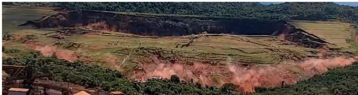
Figura 15 – Vista Frontal do início do rompimento da Barragem 1 - Mina Córrego do Feijão, Complexo Paraopeba - VALE S. A., Brumadinho/MG. Fonte: B1 – CAM1 – BARRAGEM – 25.01.2019 – 12:28:34
