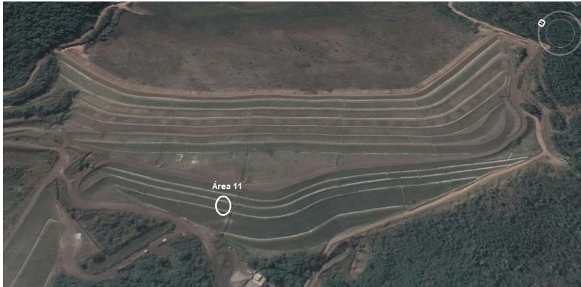
Figura 40. Imagem frontal da Barragem I com a área 11 identificada no radar. Fonte: Laudo CEAT/MPMG.
