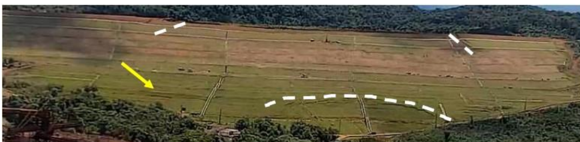
Figura 07 – Vista Frontal do início do rompimento da Barragem 1 - Mina Córrego do Feijão, Complexo Paraopeba - VALE S. A., Brumadinho/MG. Fonte: B1 – CAM1 – BARRAGEM – 25.01.2019 – 12:28:26
