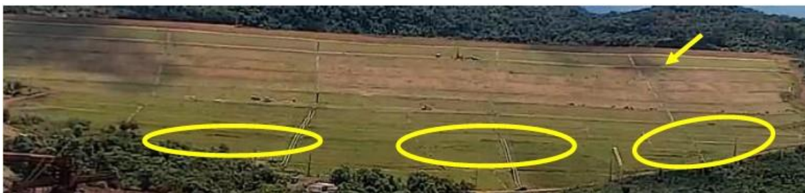
Figura 06 – Vista Frontal do início do rompimento da Barragem 1 - Mina Córrego do Feijão, Complexo Paraopeba - VALE S. A., Brumadinho/MG. Fonte: B1 – CAM1 – BARRAGEM – 25.01.2019 – 12:28:25.
