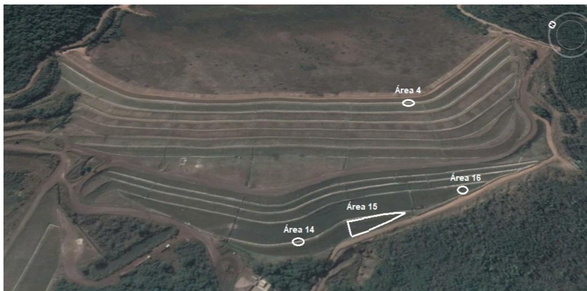
Figura 42. Imagem frontal da Barragem I com as áreas 4, 14, 15 e 16 identificadas no radar. Fonte: Laudo CEAT/MPMG.
