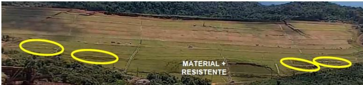
Figura 08 – Vista Frontal do início do rompimento da Barragem 1 - Mina Córrego do Feijão, Complexo Paraopeba - VALE S. A., Brumadinho/MG. Fonte: B1 – CAM1 – BARRAGEM – 25.01.2019 – 12:28:27
